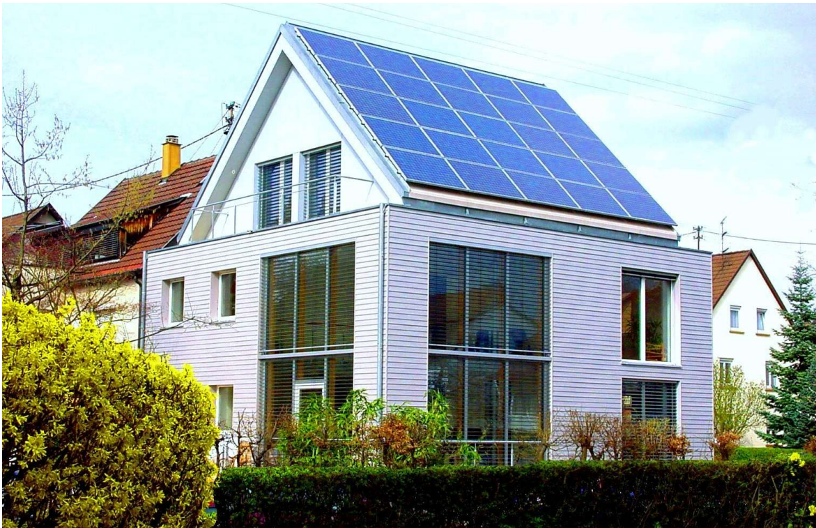
Bild 6: Plusenergie-Solarhaus mit niedrigstem Heizwärmebedarf von 11 kWh/(m 2 a) und einem 7 500 kWh/a Solarkraftwerk
