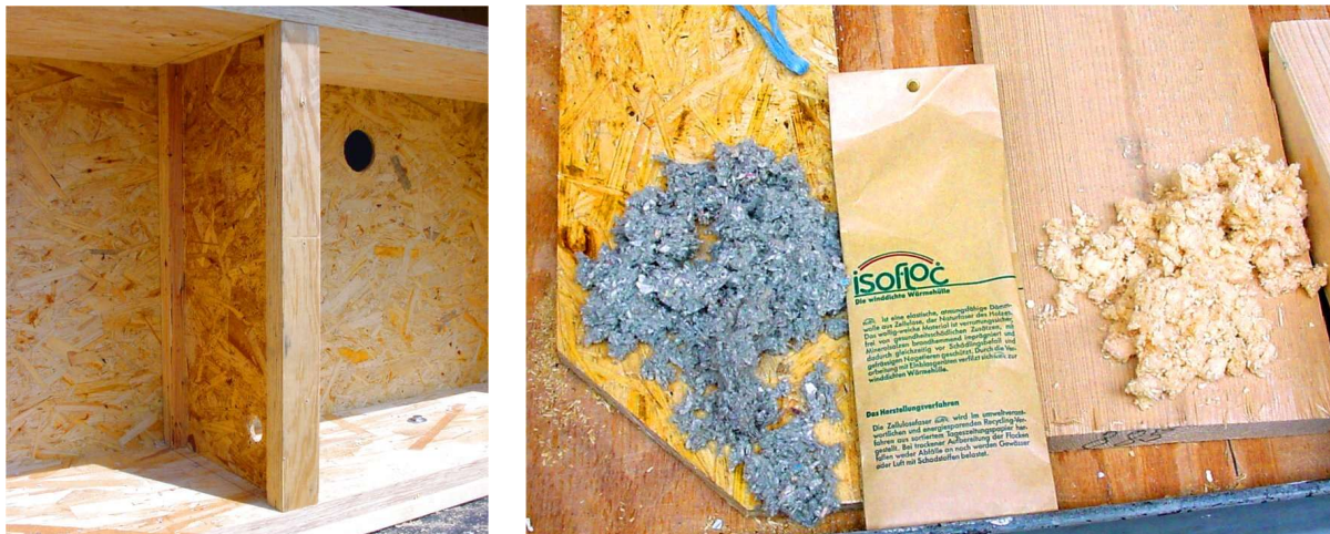
Bild 7: Doppel-T-Träger-Element aus Holz mit hoher Stabilität und geringer Wärmeleitung. Rechts das Zellulose-Recycling-Material, mit dem die Kammern gefüllt werden.
